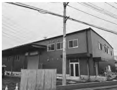
▲ 12月稼働予定の新工場
