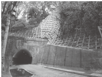
災害復旧工事後の現場の様子
